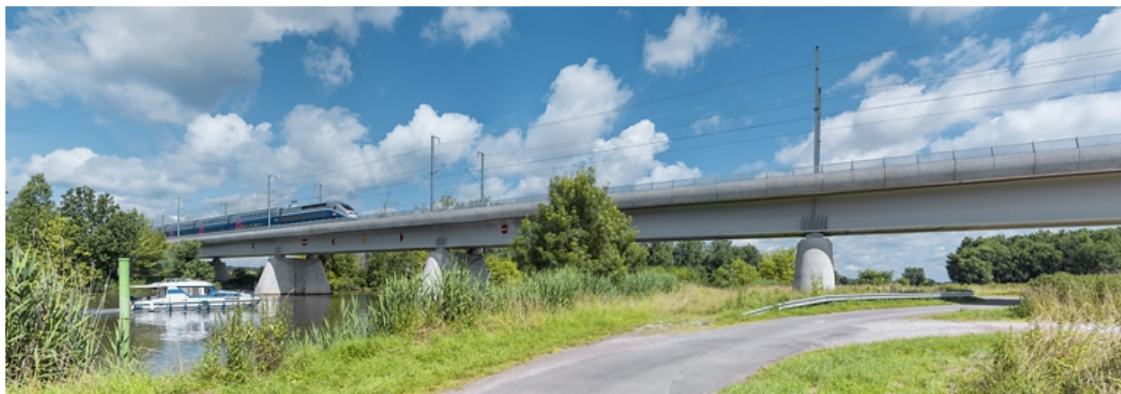
Vue d'ensemble avec TGV franchissant la Saône.
