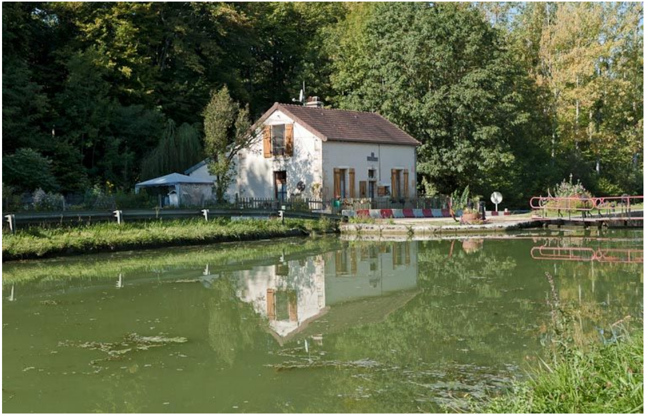
Vue du site d'écluse depuis l'amont.
