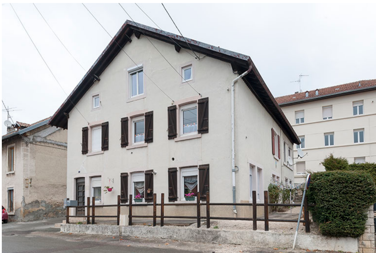
Maison : façades antérieure et latérale droite.
