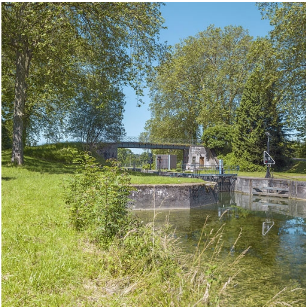
Vue d'ensemble du pont, depuis l'aval.
