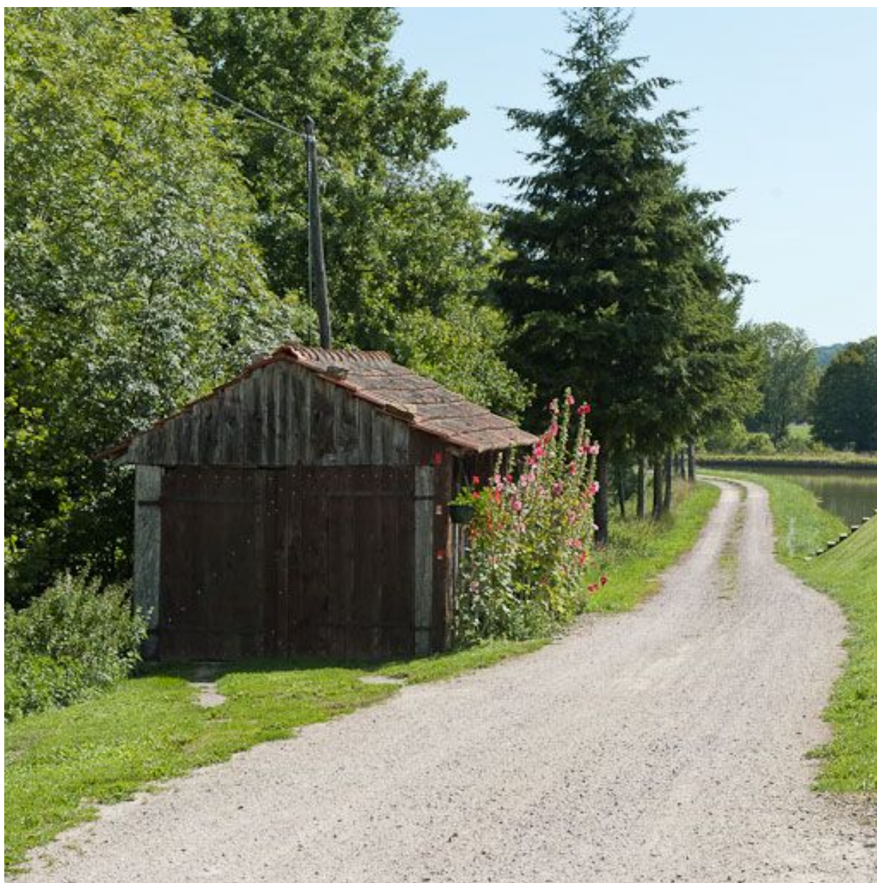
Vue de la remise en bois.
