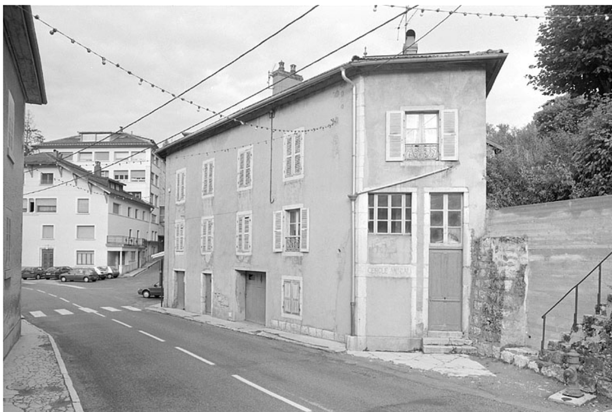
Façade sur la rue.
