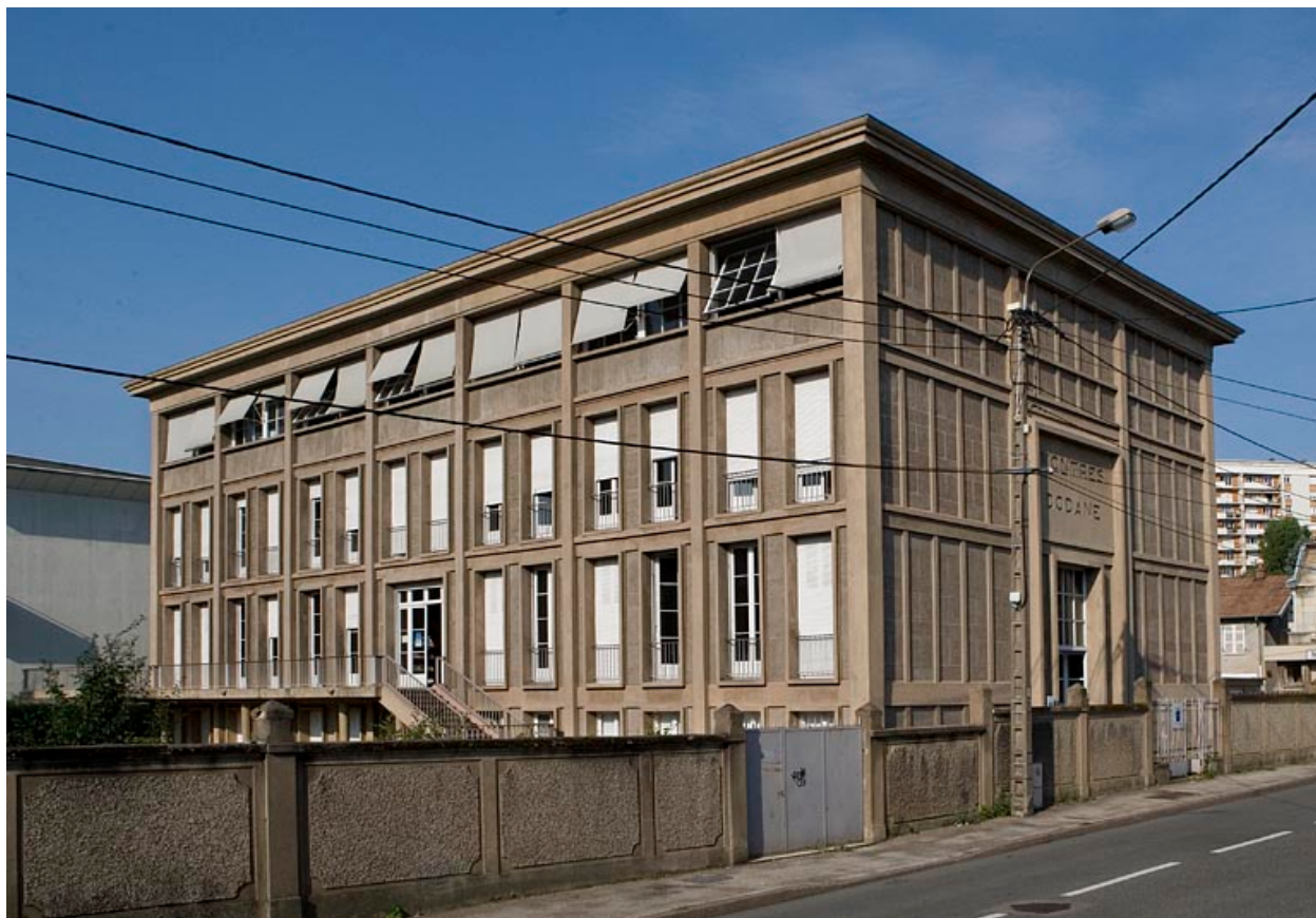
Façades antérieure et latérale gauche.
