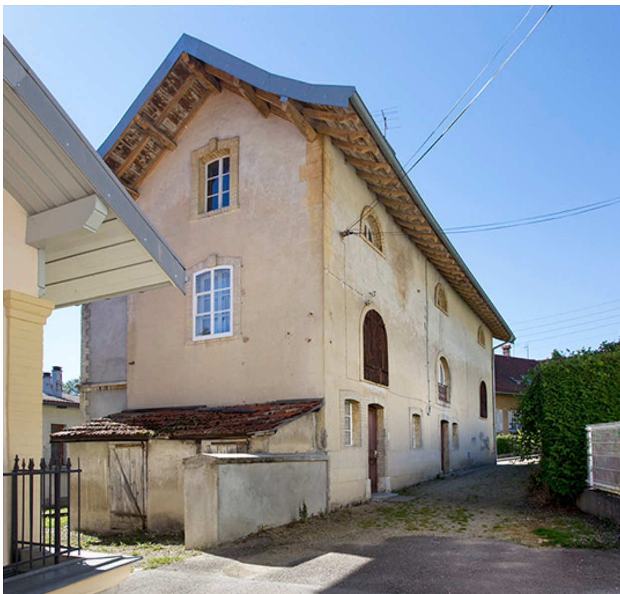
Façades postérieure et latérale droite.
