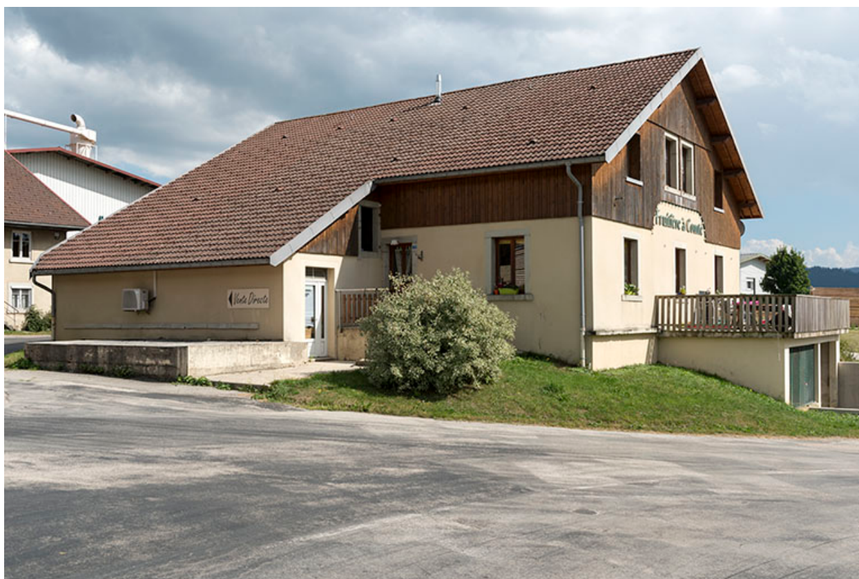
Façades postérieure et latérale droite.
