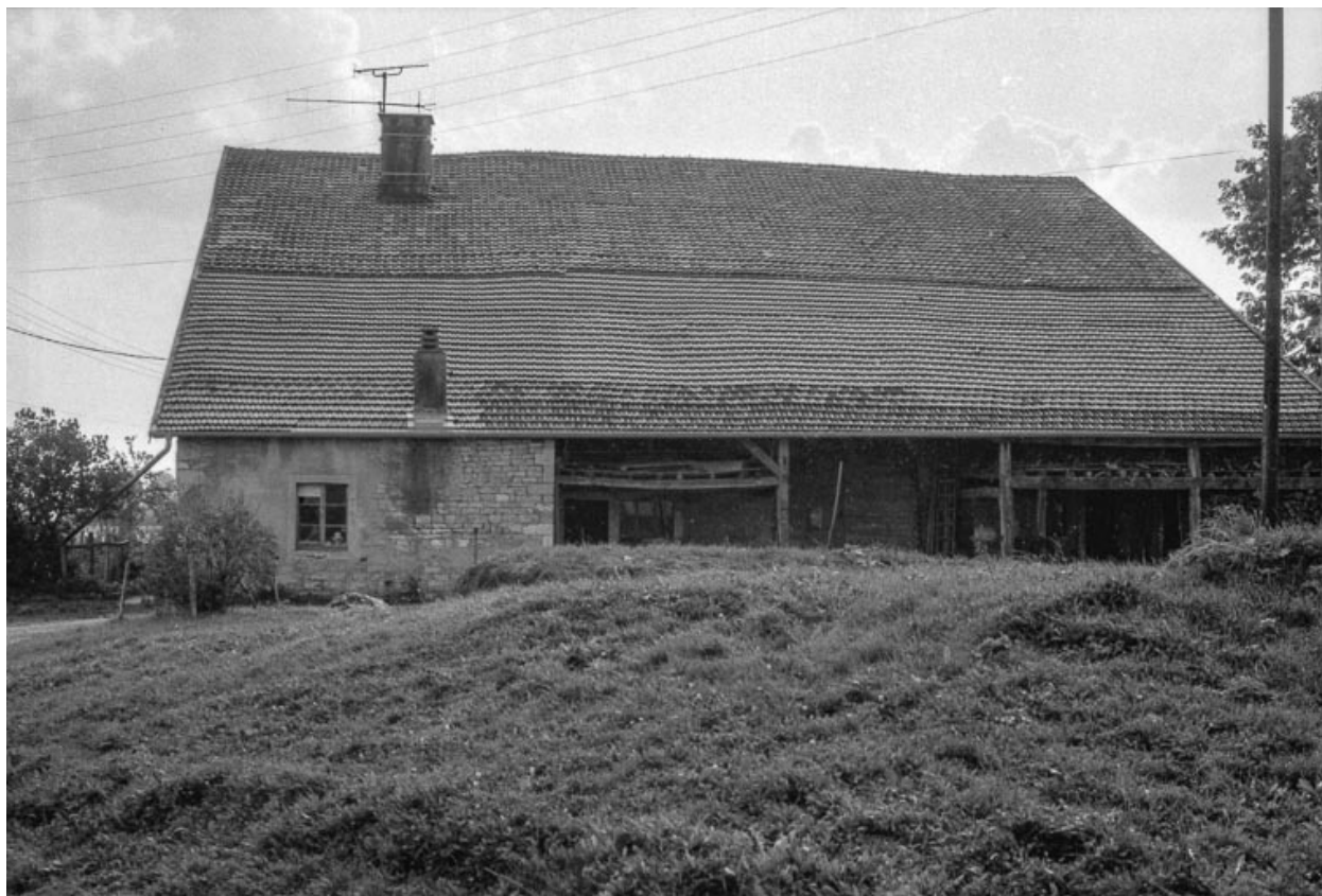
Façade latérale droite.
