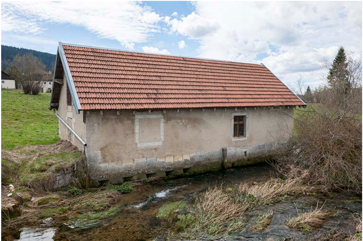
Ancienne forge. Façade nord.
