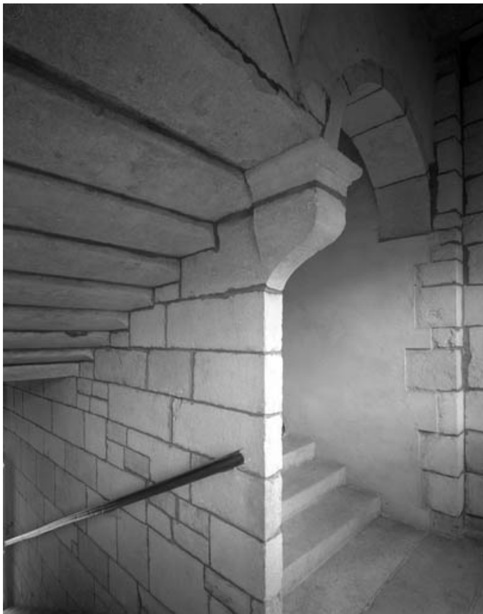
Détail de la montée d'escalier.
