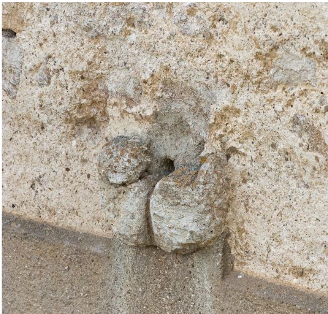
Vue de la pierre d'écoulement d'évier.
