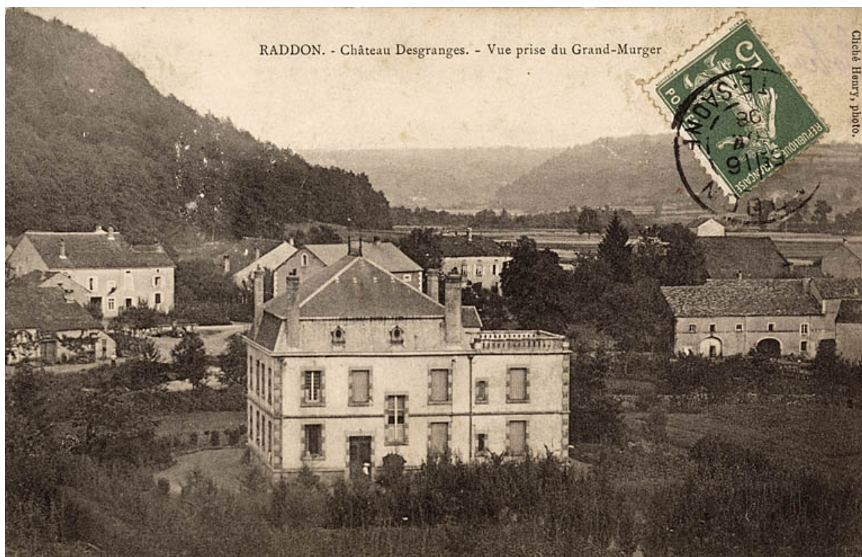
Raddon - Château Desgranges. - Vue prise du Grand-Murger.
