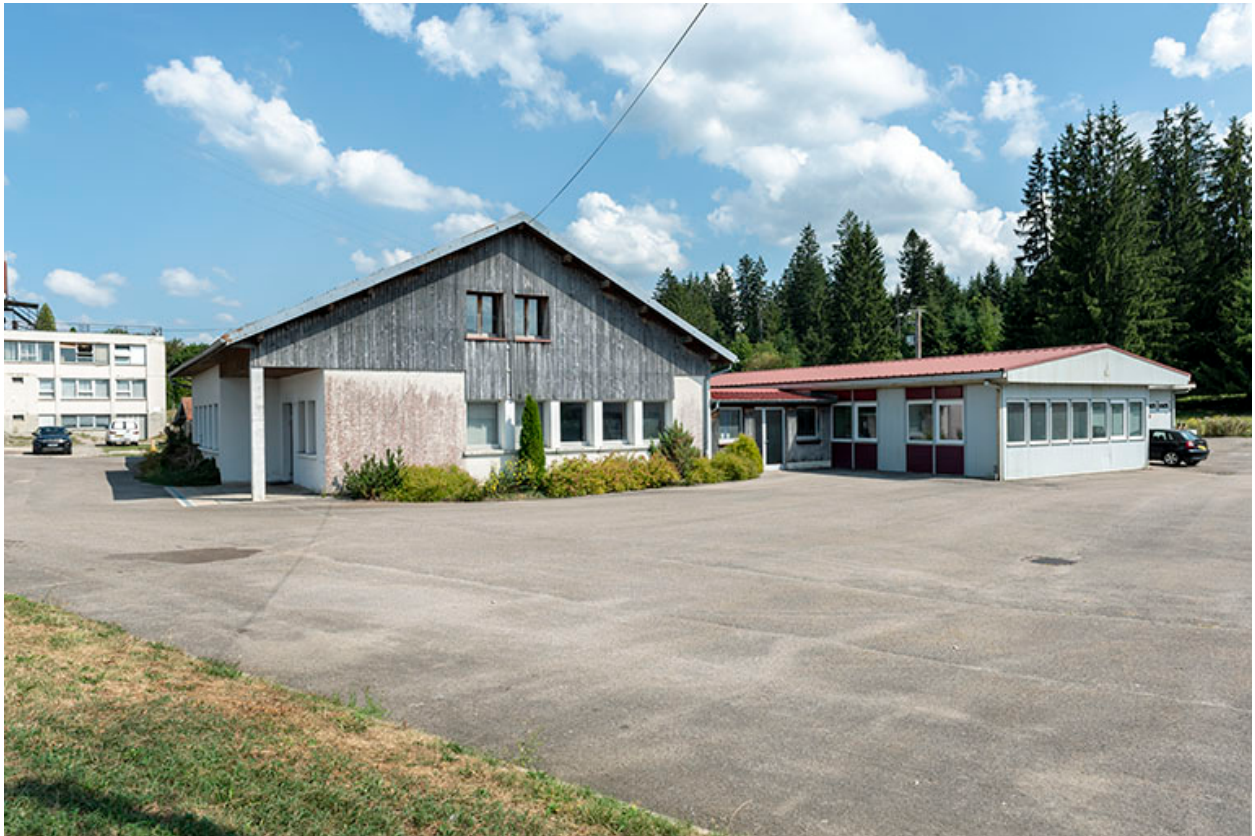
Façade latérale droite, de trois quarts gauche.
