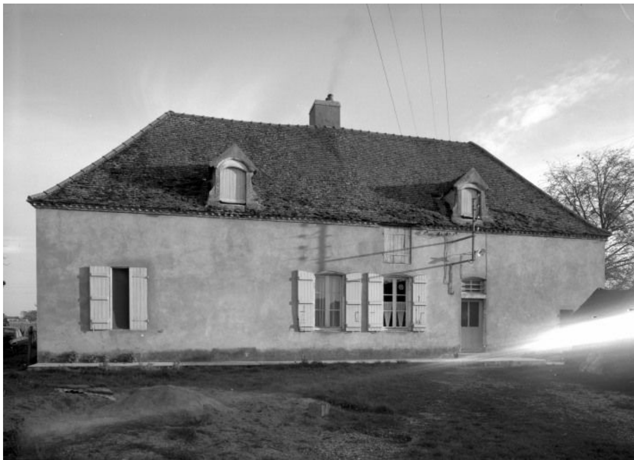
Bâtiment d'habitation, façade antérieure
