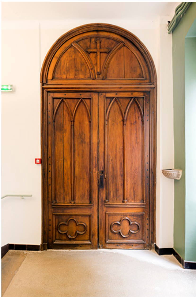
Internat : porte pallière.
