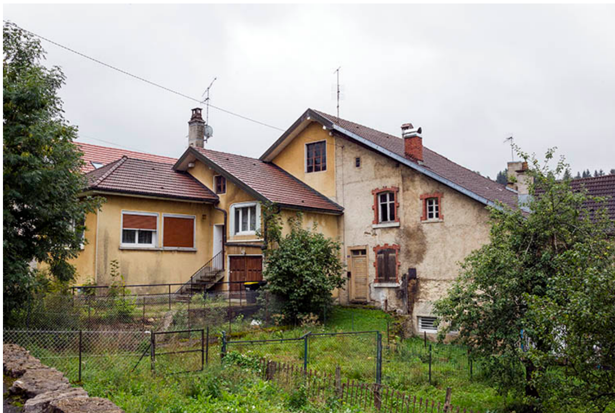
Vue d'ensemble, depuis le nord-ouest (façade postérieure).
