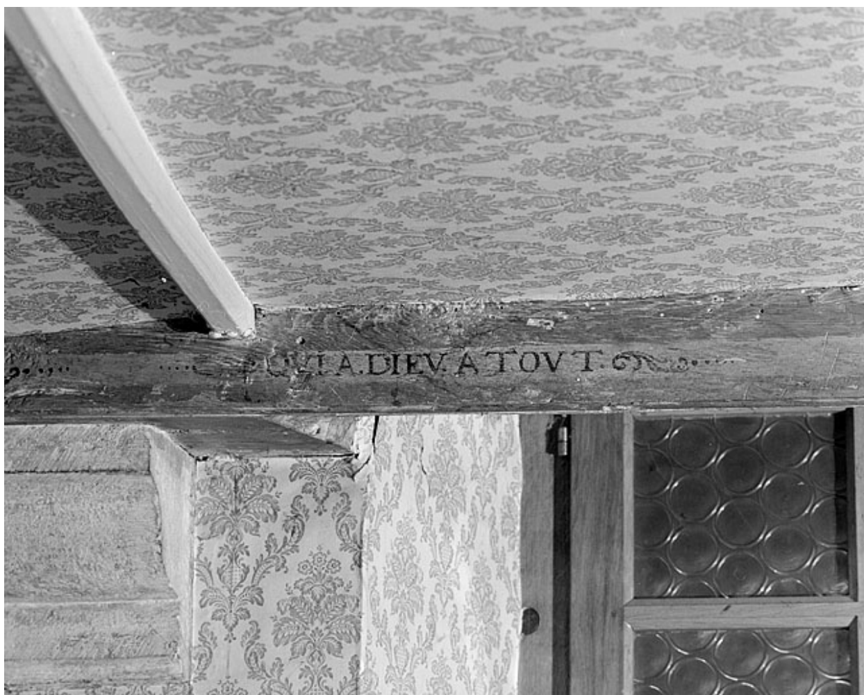
Premier corps de bâtiment. Plafond du rez-de-chaussée.
