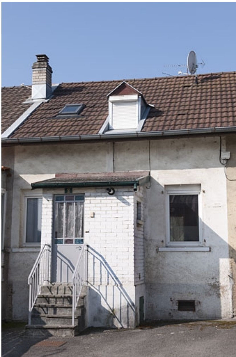
Détail d'une travée d'une habitation à 4 logements.
