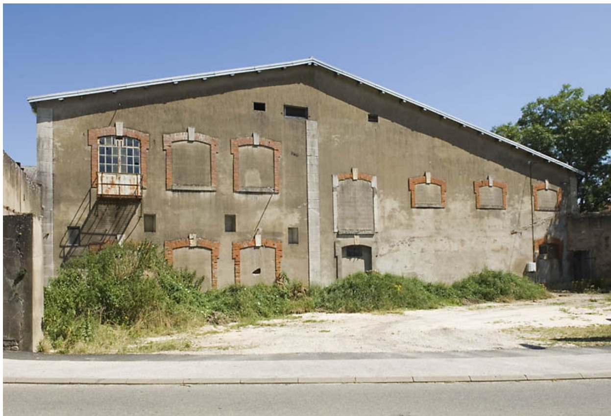
Façade sud d'ateliers de la papeterie.
