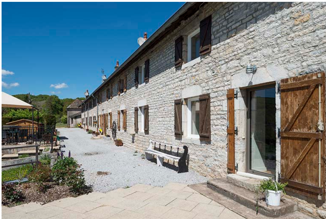
Logement ouvrier. Façade antérieure de l'aile sud.
