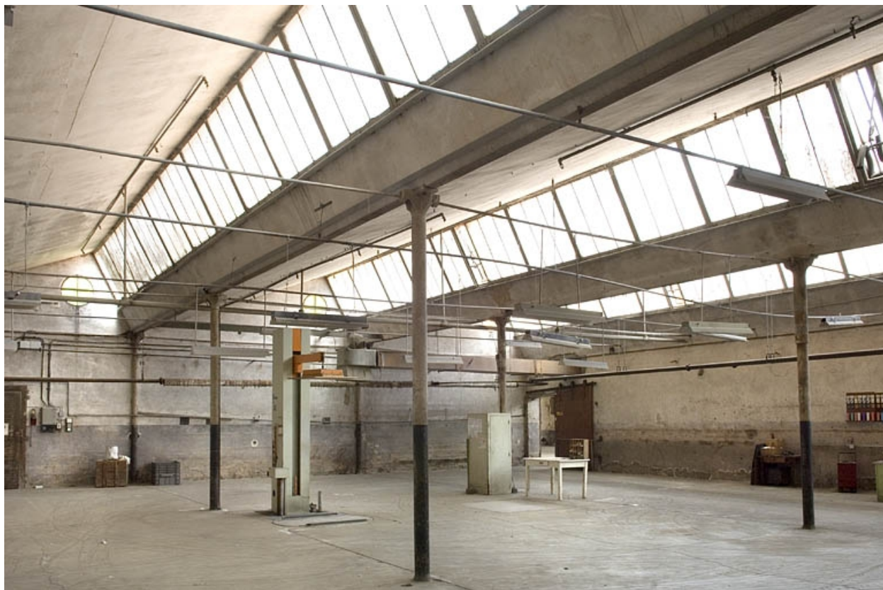
Atelier désaffecté de la filature.
