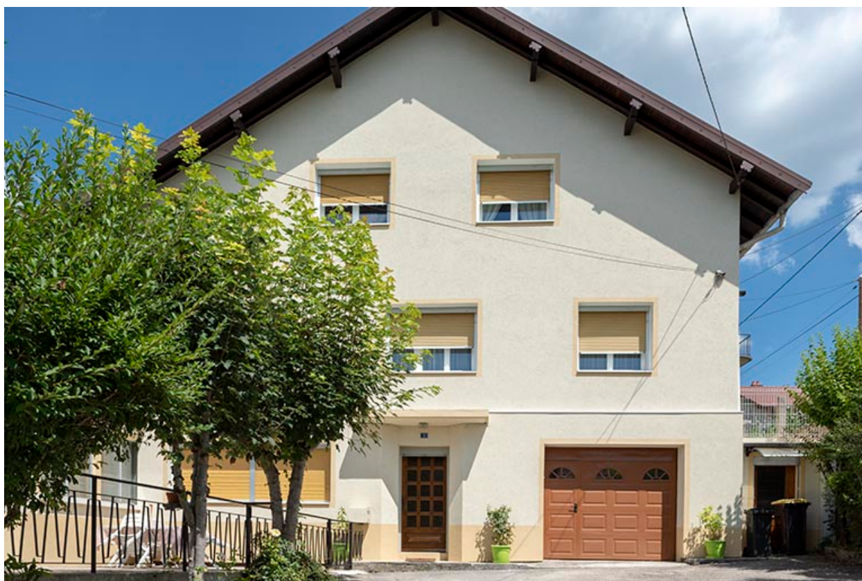
Maison : façade antérieure.
