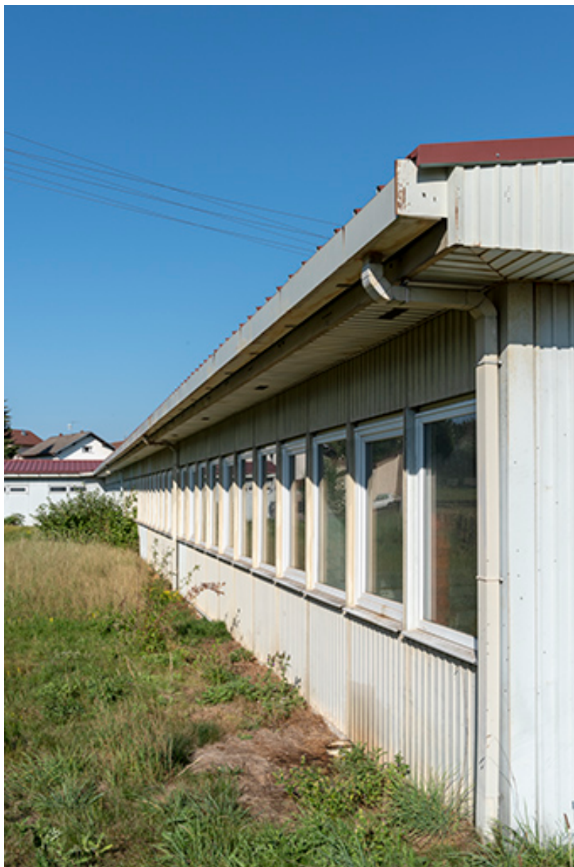
Façade postérieure, vue en enfilade.
