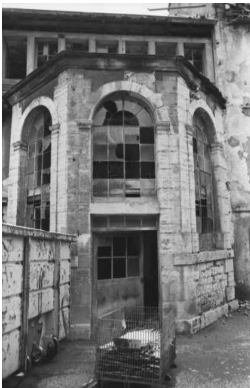
Atelier d'horlogerie. Détail de l'entrée en 1979.
