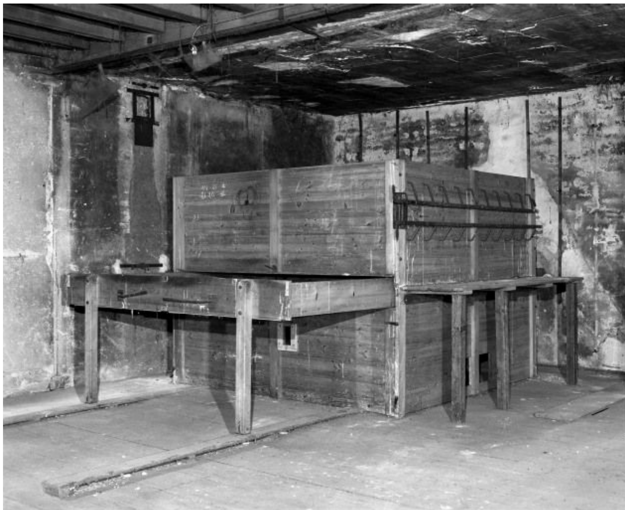
Vue d'un séchoir.
