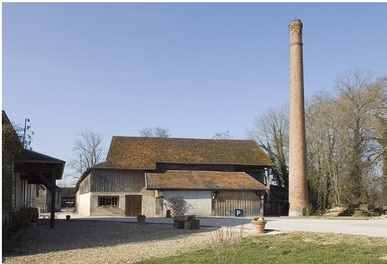
Magasin industriel et cheminée depuis le nord-est.
