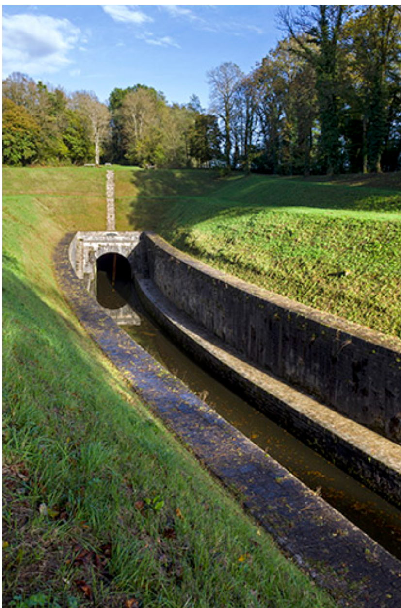
Entrée du tunnel depuis l'aval.
