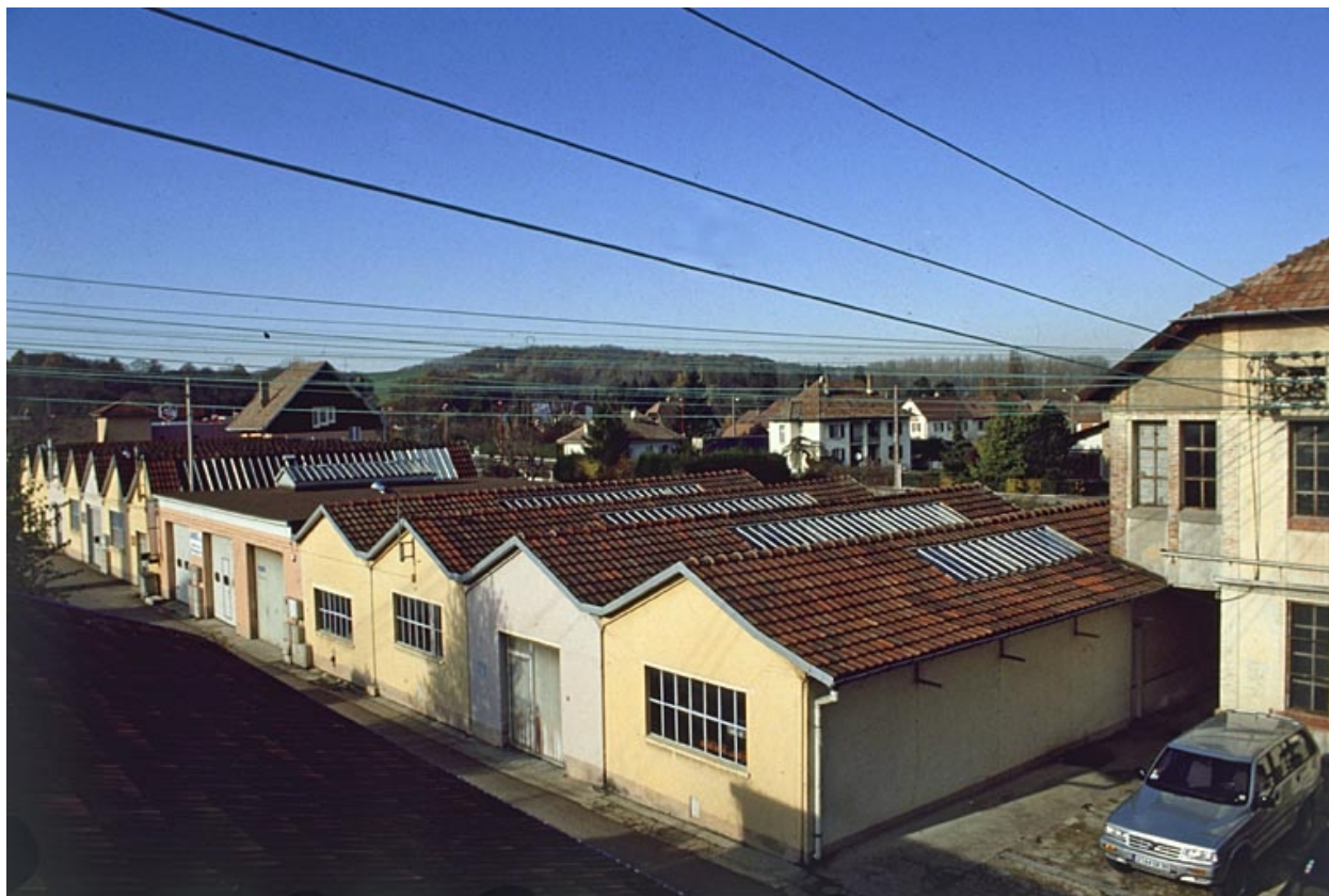
Ateliers et remises au nord.
