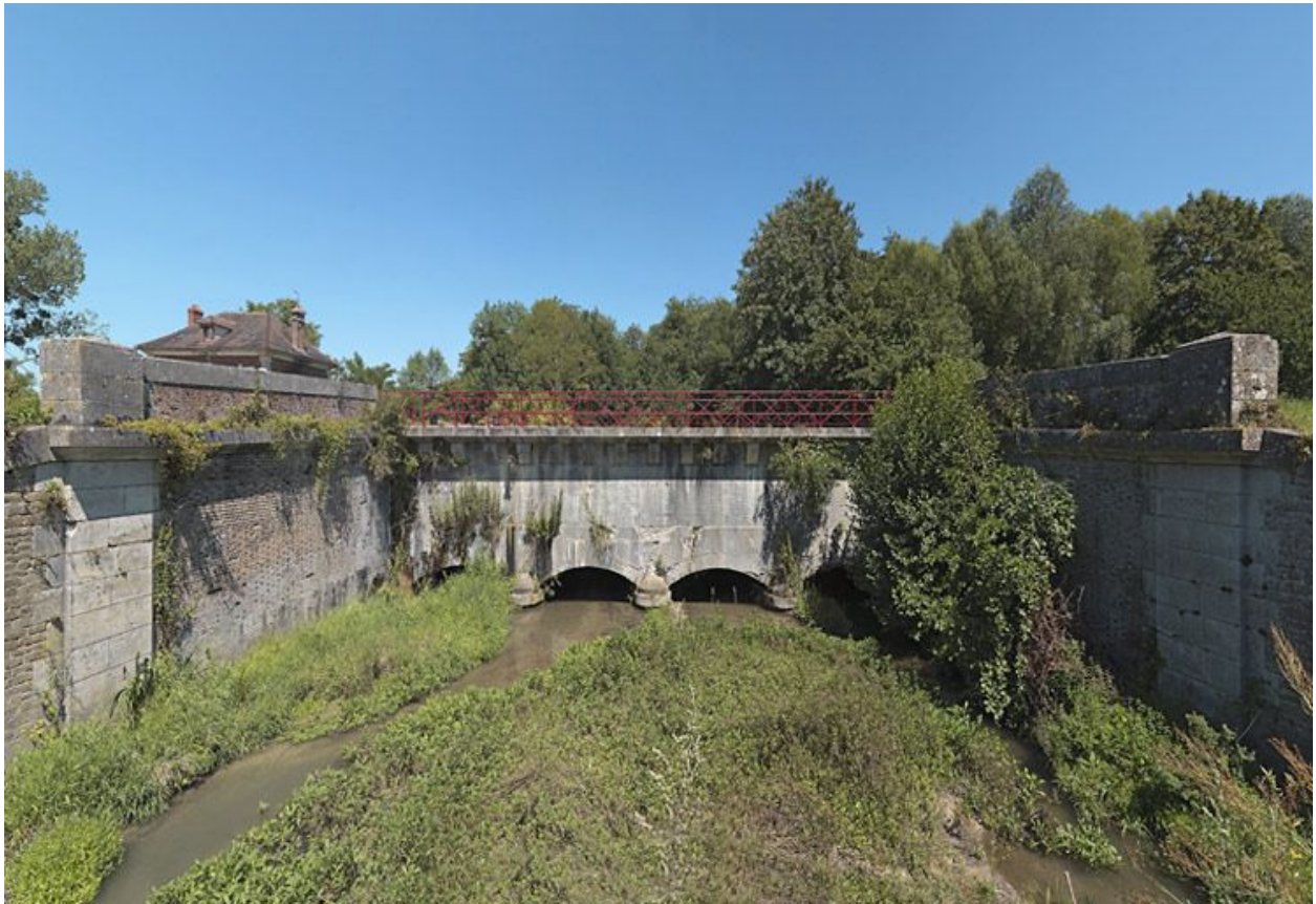
Arches du pont-canal vues de face.
