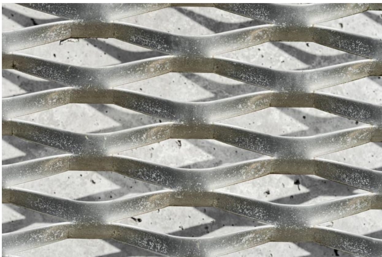
Résille métallique : détail.
