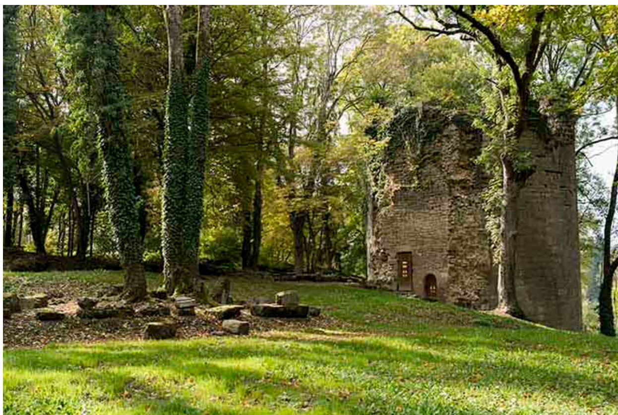
La tour ouest, vue de l'est.
