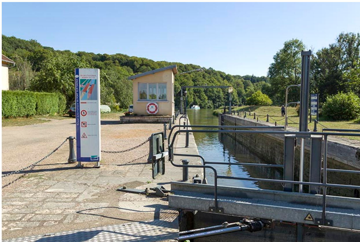
L'écluse et le poste de commande.
