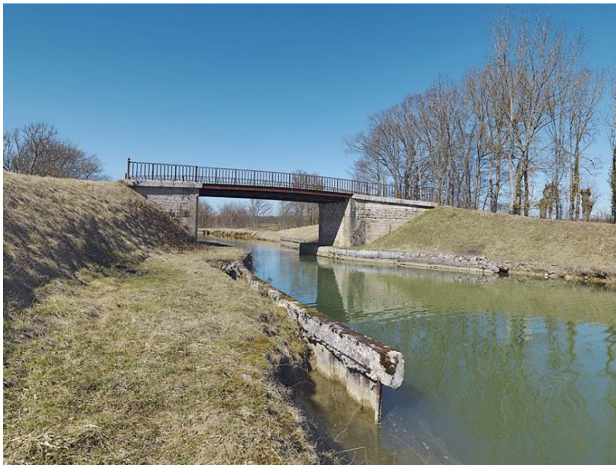
Vue d'ensemble du pont.
