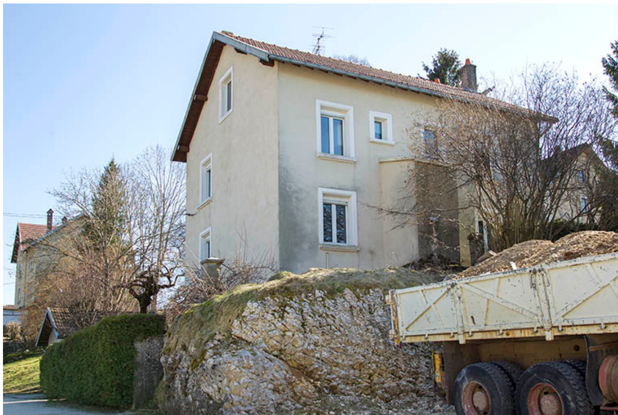
Façades postérieure et latérale droite.
