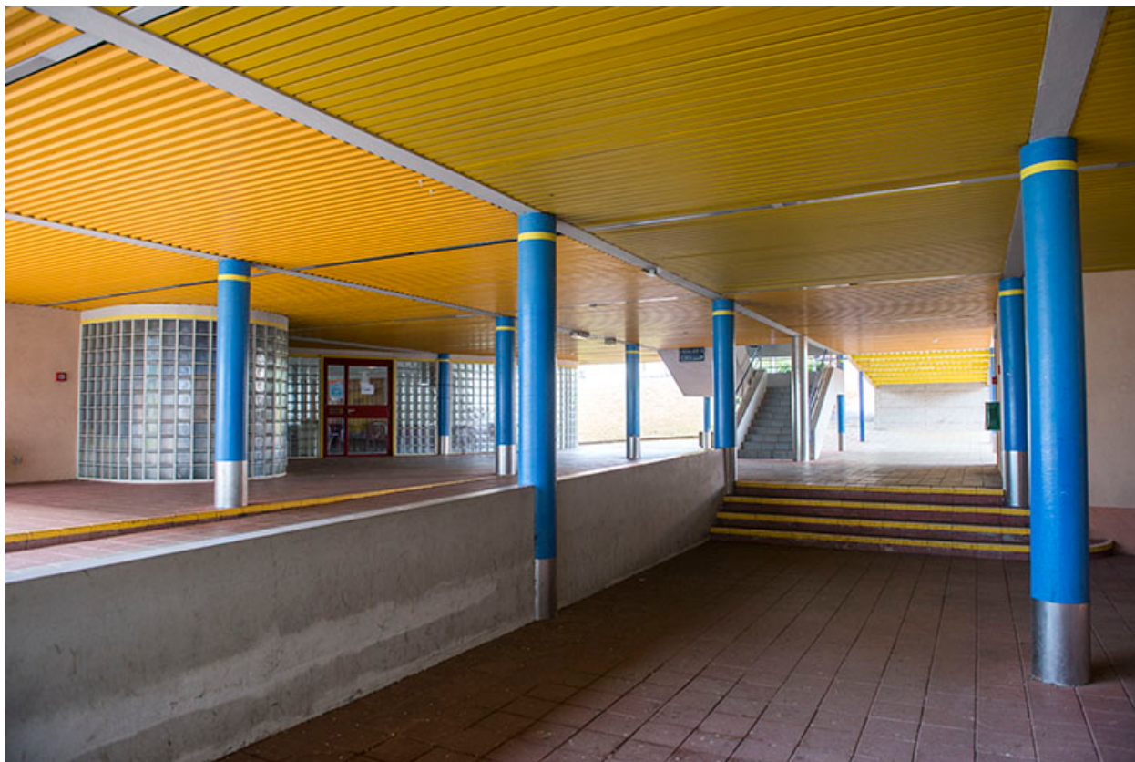
Vue intérieure de circulation abritée.
