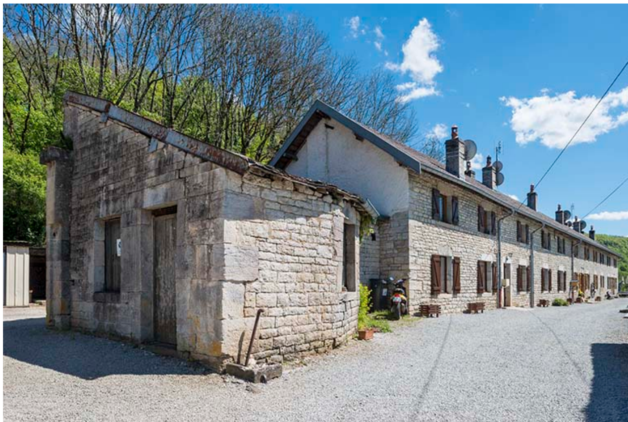
Logement ouvrier (aile sud).
