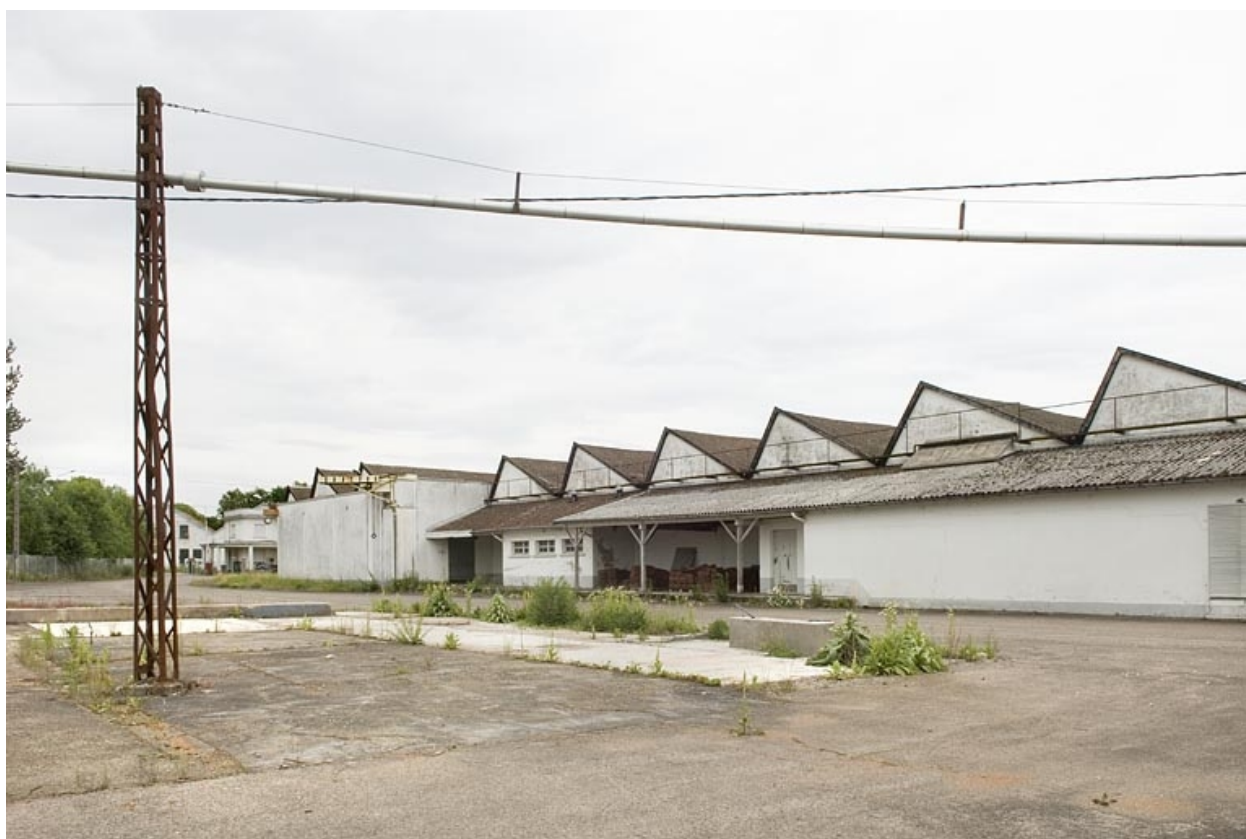
Atelier de fabrication depuis le sud-est.
