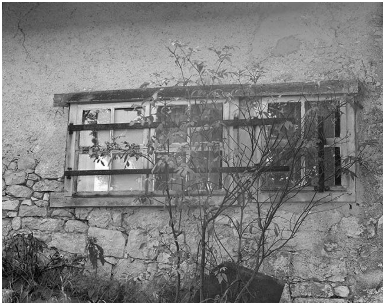
Fenêtres d'ateliers ou " fenêtres de forge ".
