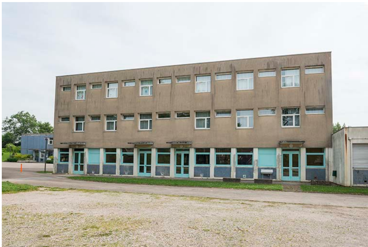
Façade sud-ouest de l'internat restauration.
