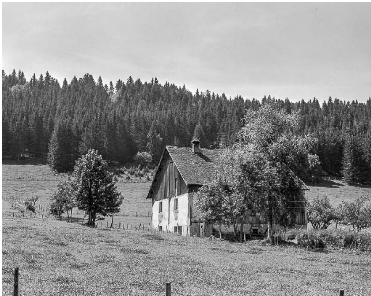
Façade latérale droite.
