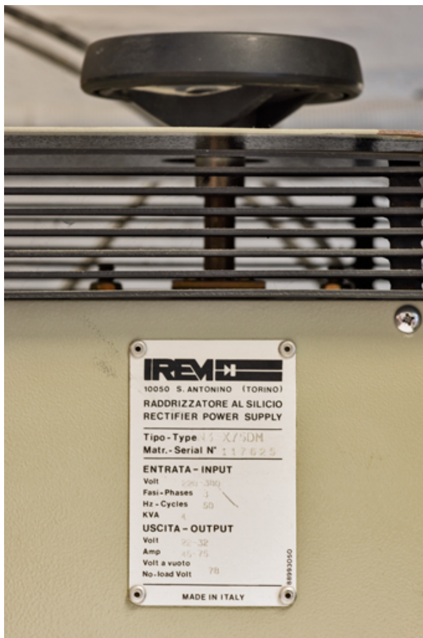
Plaque signalétique du redresseur Irem.
