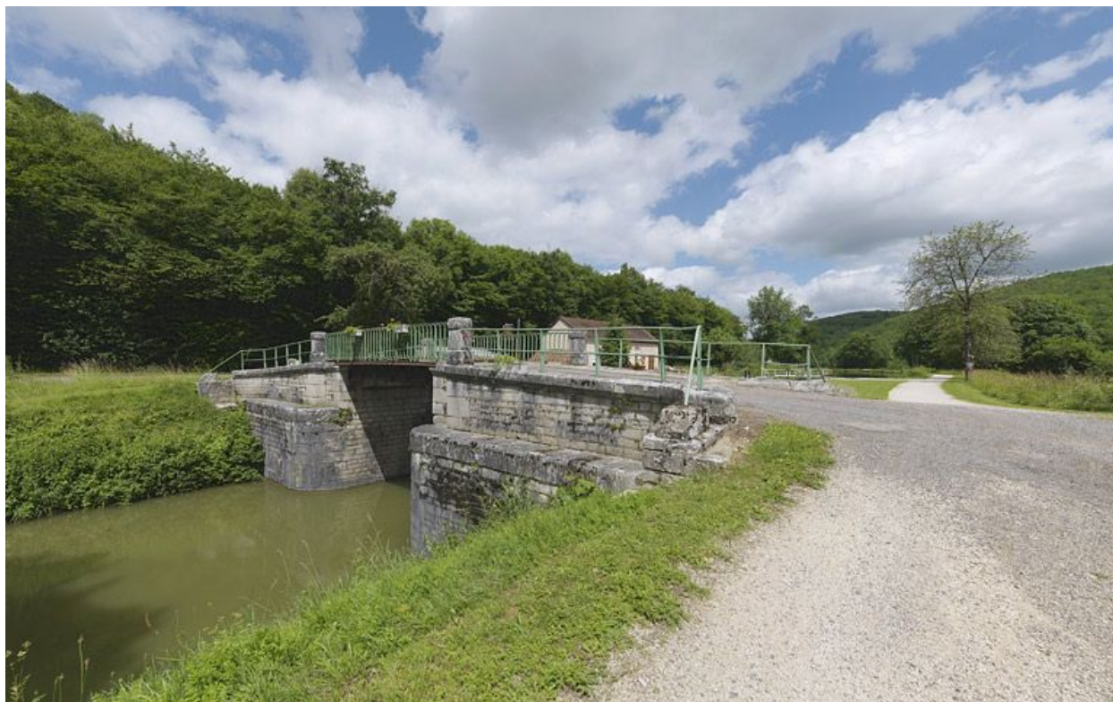
Pont vu de l'aval.
