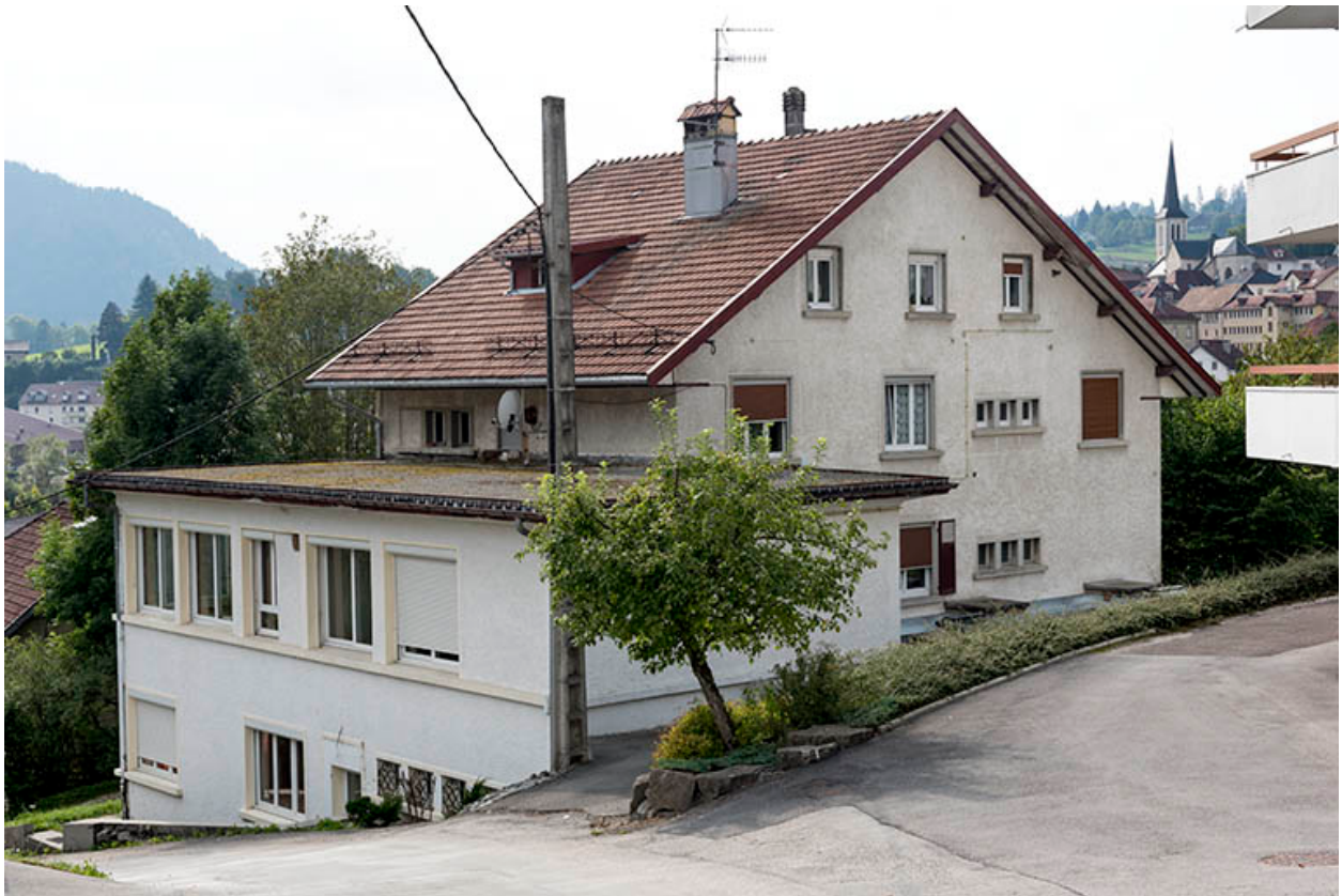
Façades postérieure et latérale droite.
