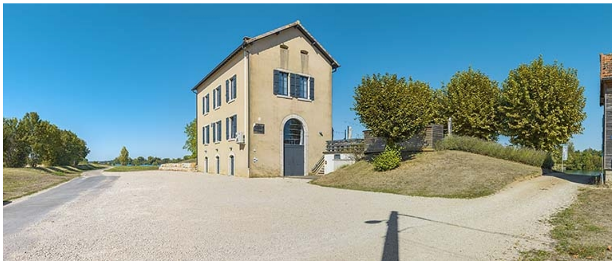
Pignon et façade postérieure de la maison.
