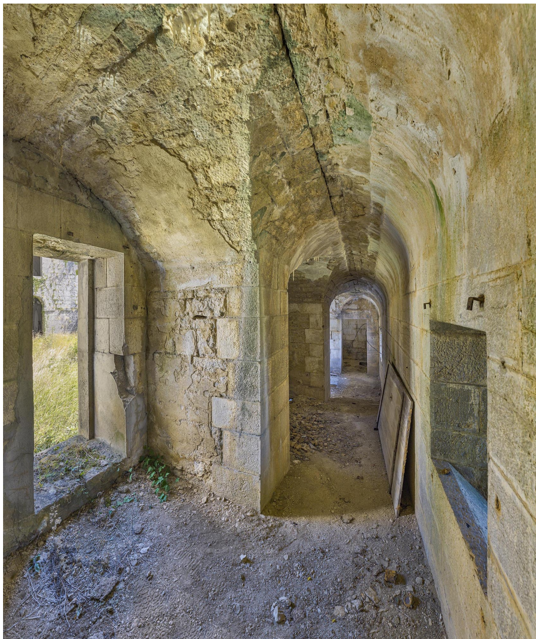
Vue intérieure de la coursière.
