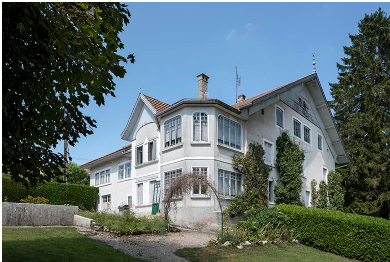
Ancienne ferme : façades antérieure et latérale droite.
