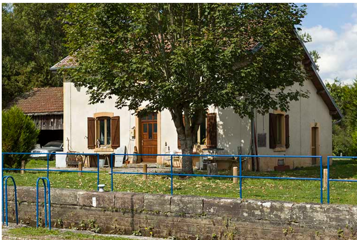
La maison d'éclusier, écluse n°39.
