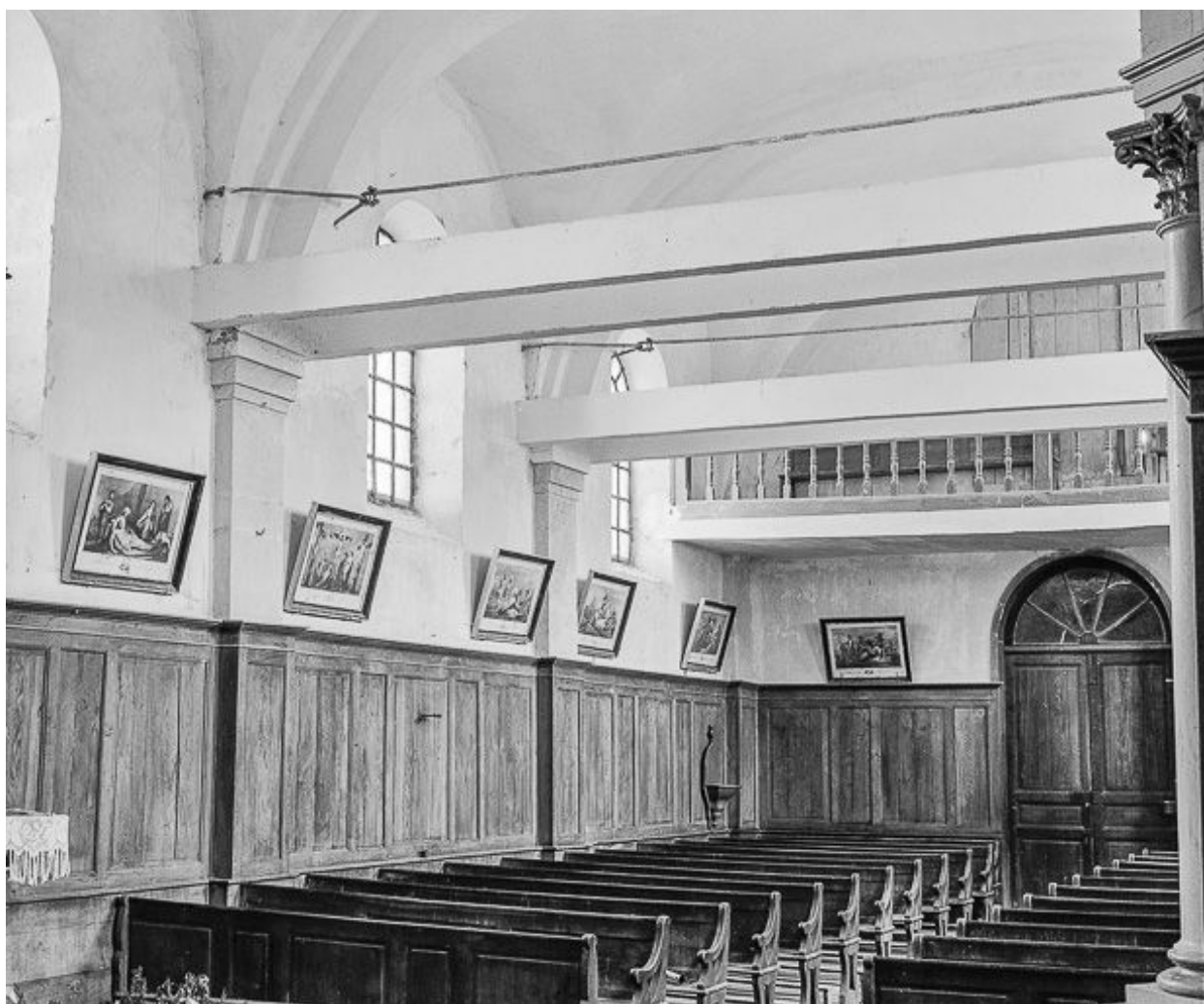
Intérieur : nef et mur latéral droit.
